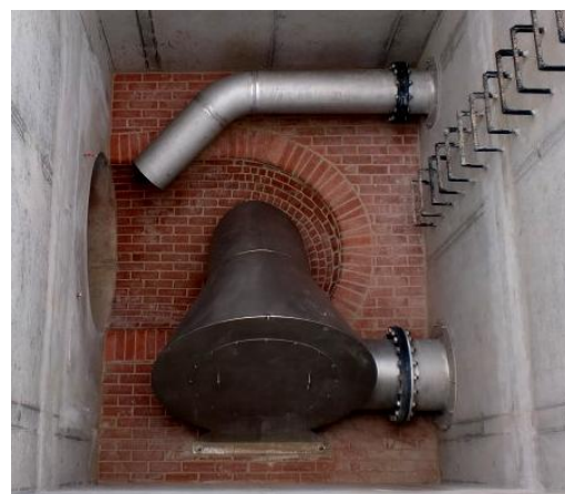
halvtørr virvelavløpsbegrenser type WAB-CY-F (oppstilling i halvtørre områder)
